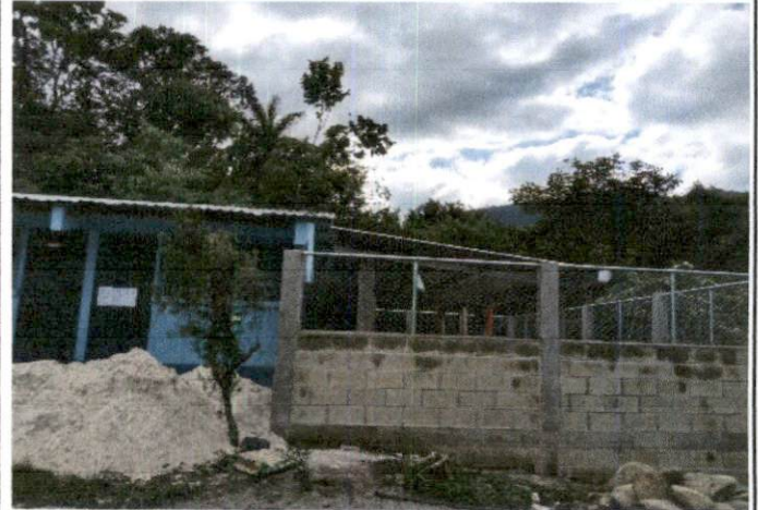
Foto 2: Mejoramiento de muro perimetral e instalación de puerta de metal para ingreso al área de sanitario finalizado.
